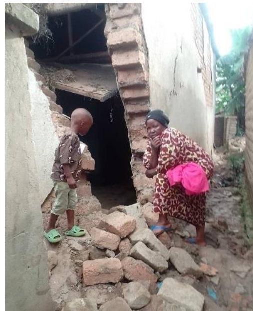
Josephine vor ihrem beschädigten Haus
