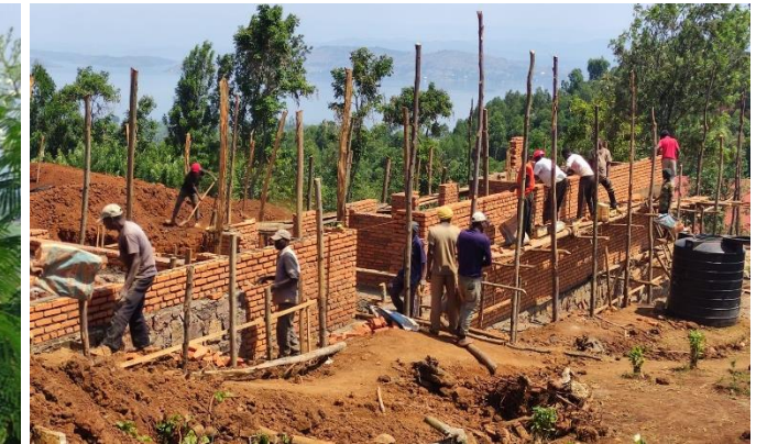
Die ersten Mauern stehen bereits
