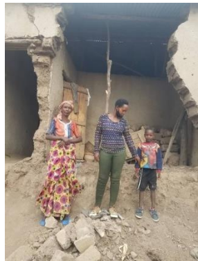
Das zerstörte Haus
